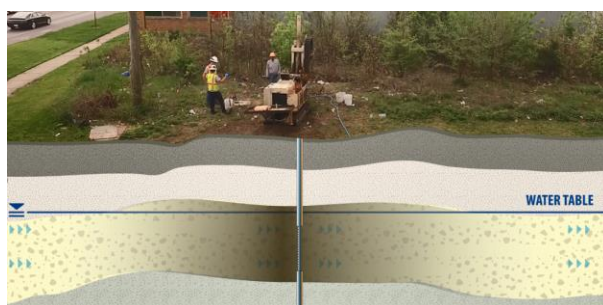
Figura 2. Iniezione mediante tecnica direct push. Rivestimento a bassa pressione delle zone di flusso permeabili.
