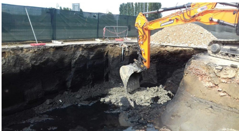
Figura 4. Attività di campo caso 1 - Applicazione di PetroFix a fondo scavo.
